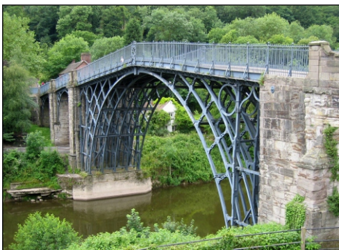
Boogbrug bij Coalbrookdale, Engeland. Een van de eerste ijzeren bruggen, gebouwd in 1780.
